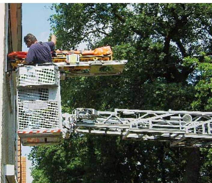
Abb. 2: Feinpositionierung des Korbes vor dem Fenster im ersten Stock
